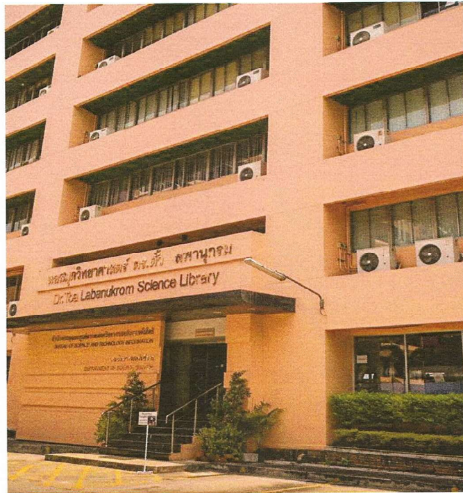
อาคารหอสมุดวิทยาศาสตร์ ดร.ตัว ลพานุกรม (ฝั่งห้องสมุด) สูง 6 ชั้น
